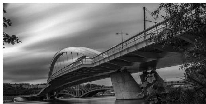
Bild 1 Höherfester thermomechanisch gewalzter Stahl (S460ML) im Brückenbau, Raymond Barre Brücke in Lyon, Frankreich Higher strength thermomechanically rolled steel (S460ML) in bridge construction, Raymond Barre Bridge in Lyon, France
