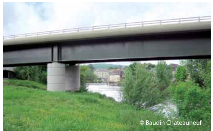
Viaduc de Larche, France, 2008, 310 t de tôles PL S355N/NL jusqu'à 120 mm d'épaisseur
