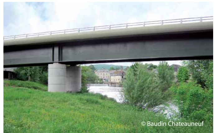
Larche Viadukt Frankreich, 2008, 310 t LP-Bleche S355N/NL bis 120 mm Dicke
