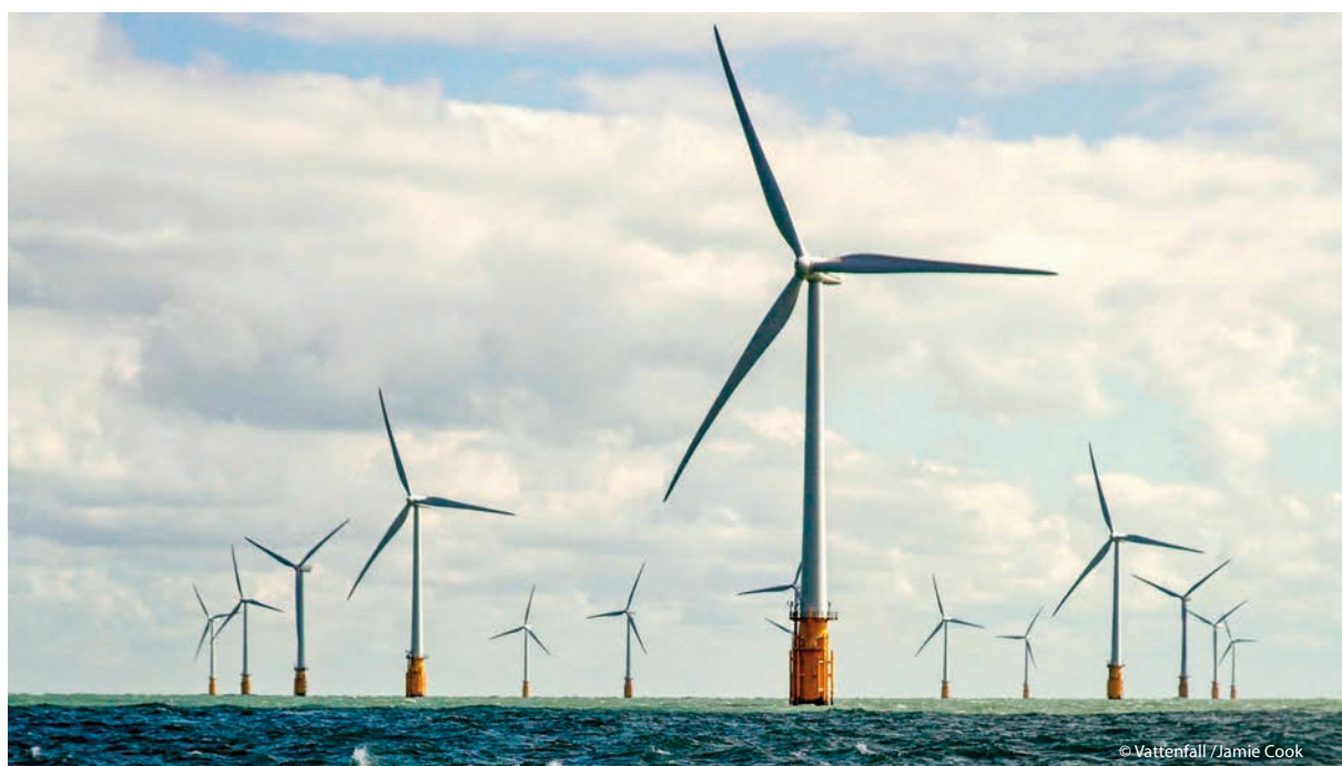
DI-MC – sicheres Standbein der erneuerbaren Energie: Offshore Wind Park Thanet, gebaut mit thermomechanisch gewalztem Stahl von Dillinger
