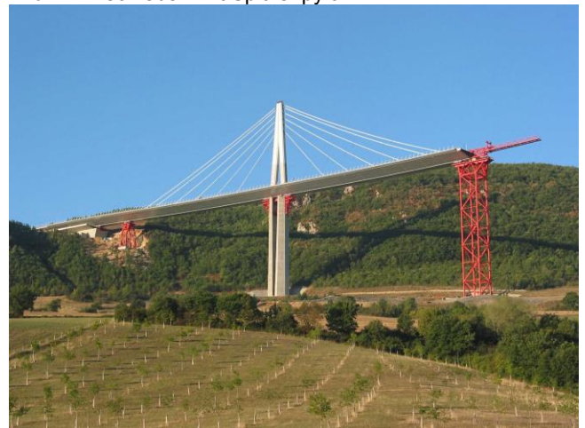
Bild 7: Einschieben mit Spitzenpylon
