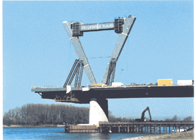
Bild 9. Pylone der neuen Autobahnbrücke Düsseldorf Fig. 9. Pylons of the new highway bridge Düsseldorf-airport
