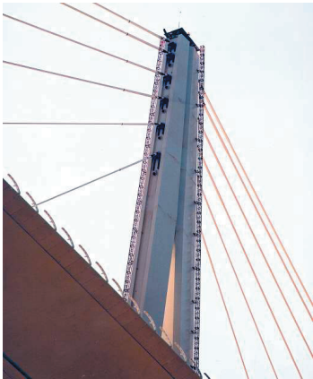
Bild 4 Pylone während der Montage
