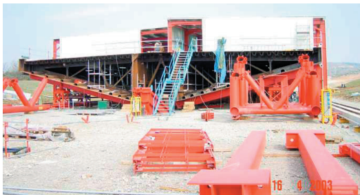
Bild 9 Kastenträger des Decks Bild 9 stellt den verschweißten Deckträger am Vormontageplatz dar.
