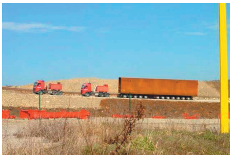
Bild 7 Transport der Mittelkästen zur Baustelle
