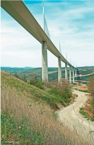
Bild 12 Die Brücke nach Fertigstellung
