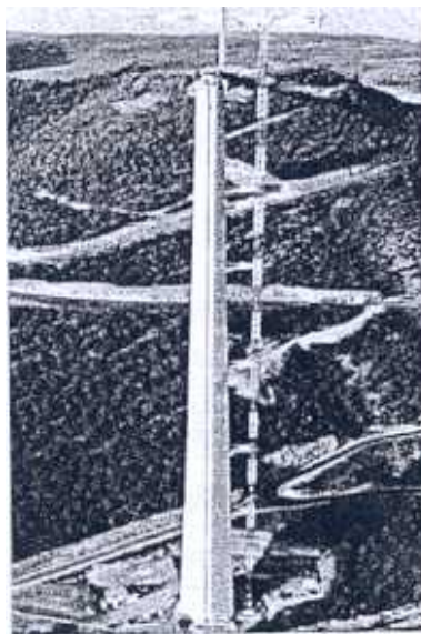
Bild 3. Konstruktion der Brückenpfeiler [1] Fig. 3. Construction of the piers [1]
