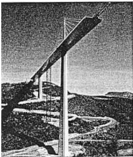
Bild 12. Blick auf das nördliche Widerlager Anfang Mai 2004 Fig. 12. Northern abutment beginning of Mai 2004
