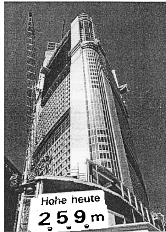
Bild 16. Commerzbank-Gebäude in Frankfurt/Main aus TM-Stahl-Blechen
