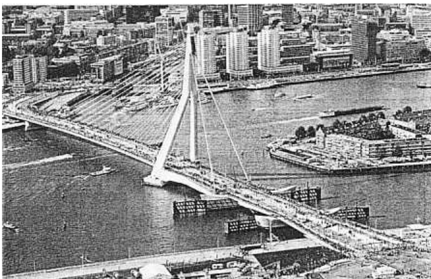
Bild 18. Erasmus-Brücke in Rotterdam aus TM-Stahl
