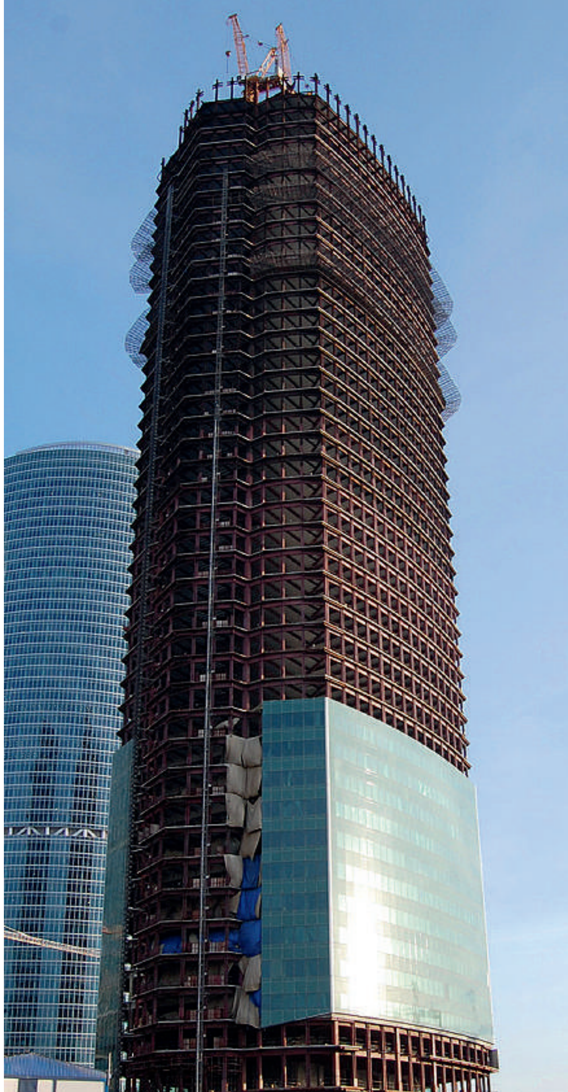
High-Tech-Bleche der Dillinger Hütte für den Wolkenkratzer „Eurasia Tower“ in Moskau (Foto mit freundlicher Genehmigung von Bradmoscu)
