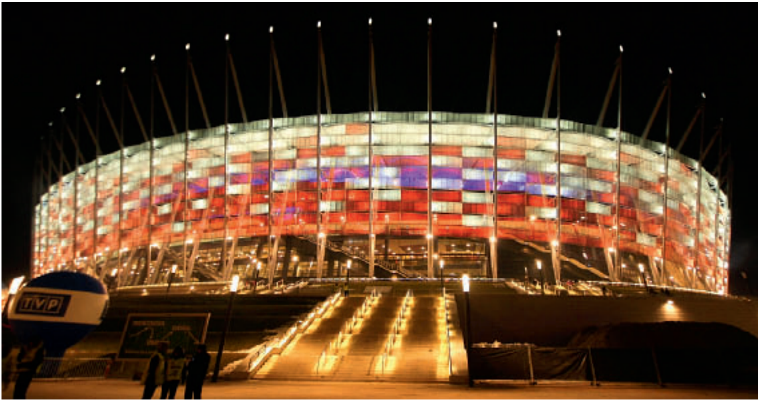
Pour le stade de Varsovie, dans lequel a lieu le match d'ouverture du championnat d'Europe de football 2012, Dilling a livré environ 900 tonnes de tôles fortes laminées thermo-mécaniquement. (Photo avec l'aimable autorisation de Mateusz Włodarczyk)
